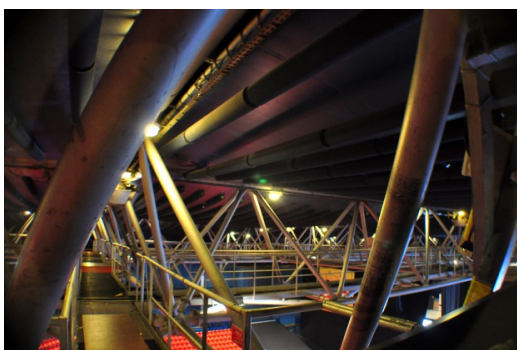
Passerelles suspendue via des poutres installées « en treillis ».
